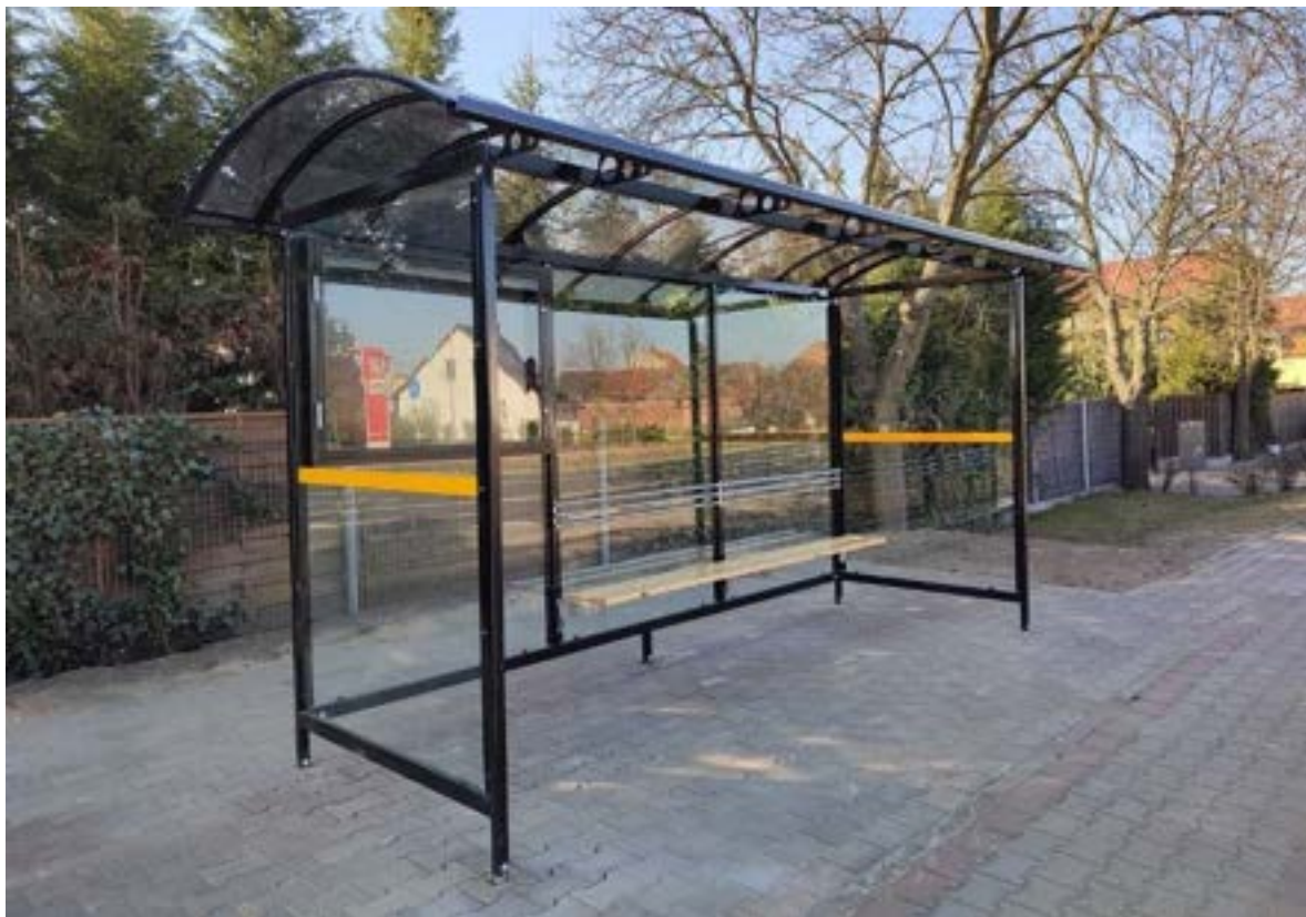
Zdjęcie 15. Wiata przystanku autobusowego komunikacji miejskiej w Nowej Soli
