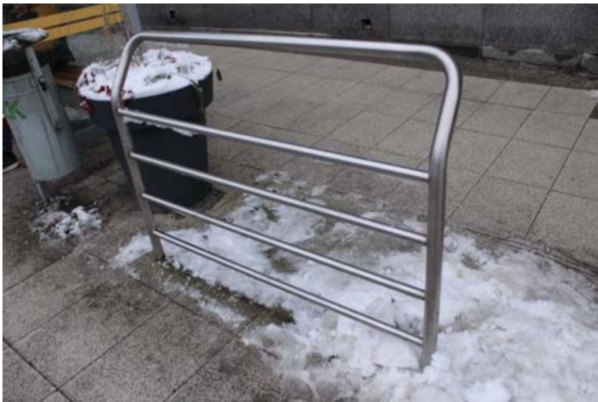
Zdjęcie 25. Przykład podpórki dla pieszych zamontowanej przy przystanku autobusowym (Zielona Góra)
